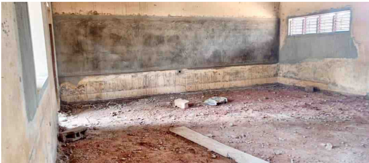
Entkernter Fußboden
